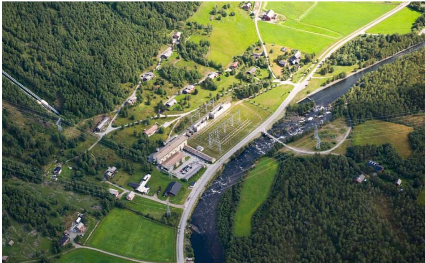
I kraftstasjonen Hol 1 er ett av i alt fire aggregater skiftet ut i 2009.
