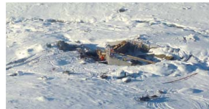
Rehabilitering av sideinntaket Storagrovi.
