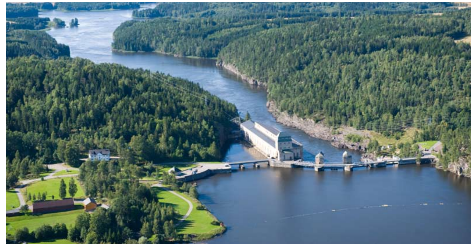
Solbergfoss kraftstasjon i Glomma.
