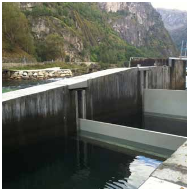
Problem med styringssystem og signalene fra vannstandsmålere i Vassbygdvatn og ved utløpet av fisketrappa i Aurlandselva forårsaket begge miljøavvikene som ble avdekket i 2011.
