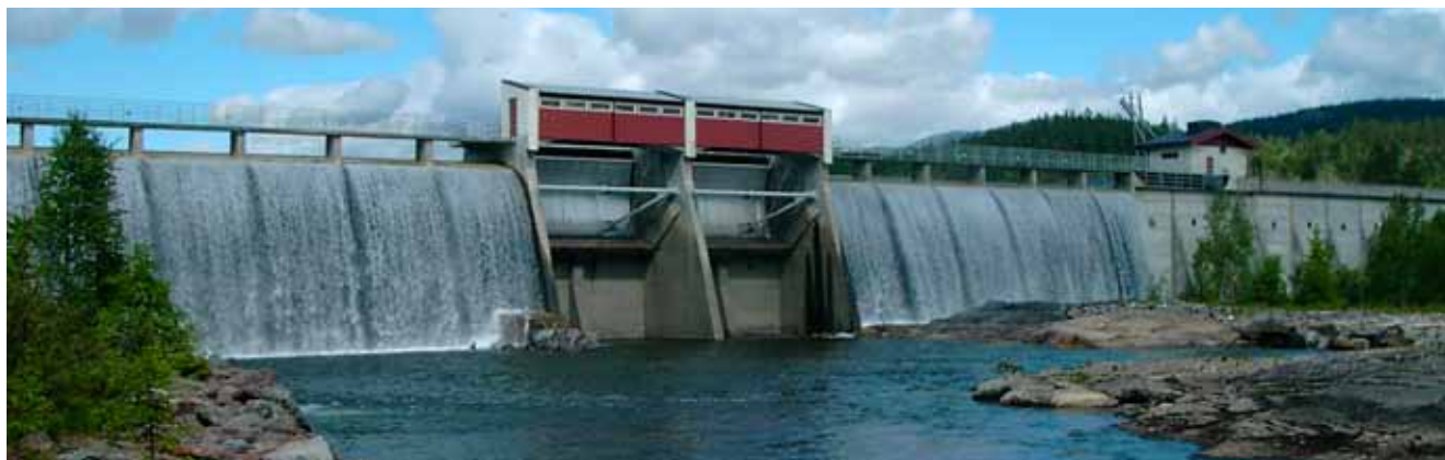
Eikredammen, inntaksmagasin for kraftverket Hemsil 2.
