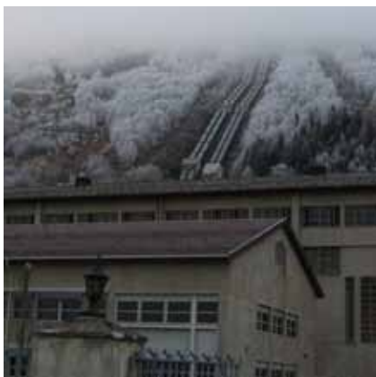
Støysisolering av rørgata har vist seg som et effektivt tiltak for å dempe støyen fra kraftstasjonen Hol 1.
