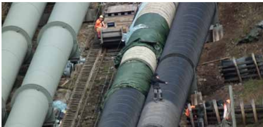
Støysisolering av rørgata har vist seg som et effektivt tiltak for å dempe støyen fra kraftstasjonen Hol 1.
