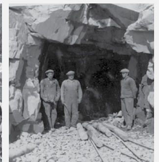
Tilløpstunneler og kraftstasjoner ble også bygget inne i fjellet.
