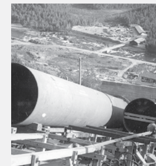
Ved den første kraftutbyggingen ble tilløpsrør lagt synlige i dagen.
