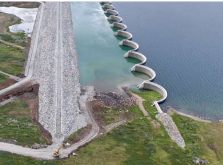
E-CO har bygget en ny steinfyllingsdam ved Stolsvatn til erstatning for den gamle betongdammen fra 1947. Den nye dammen sto ferdig i 2009.
